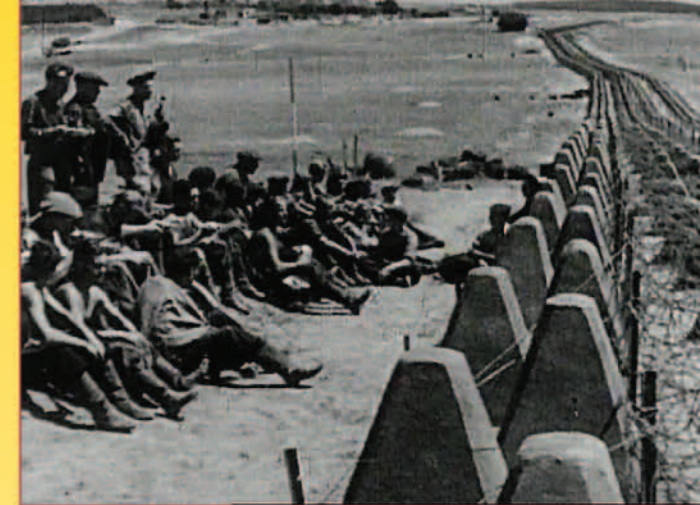
Bauarbeiten an der Höckerlinie - Foto: National Archives
